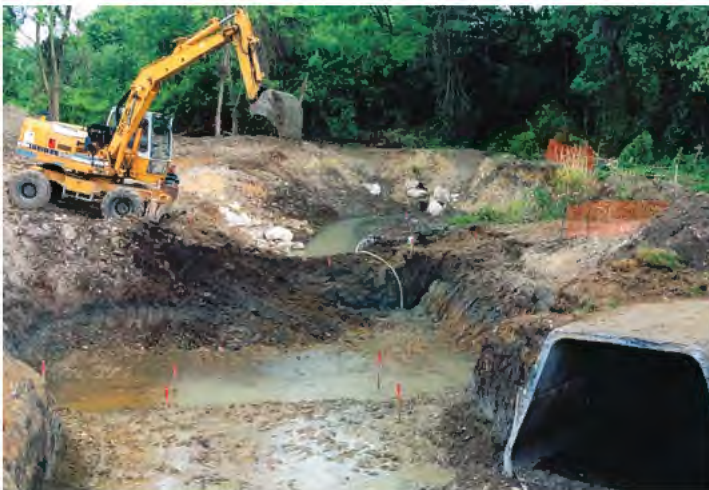
Le parc de Fresnes pendant les travaux en 2003.
