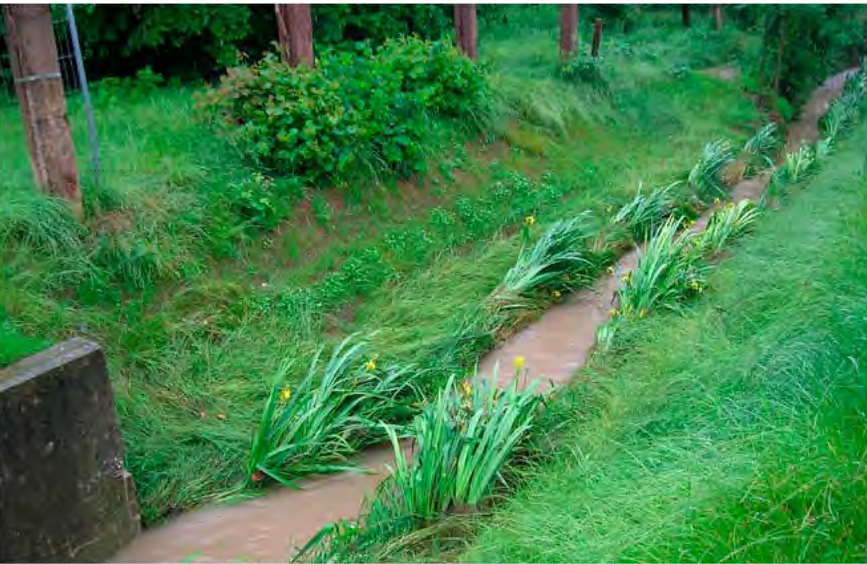
Pose dans le lit de la rivière de boudins d'hélophytes en bas de berges raides, (Muhlbaechel à Vendenheim)
