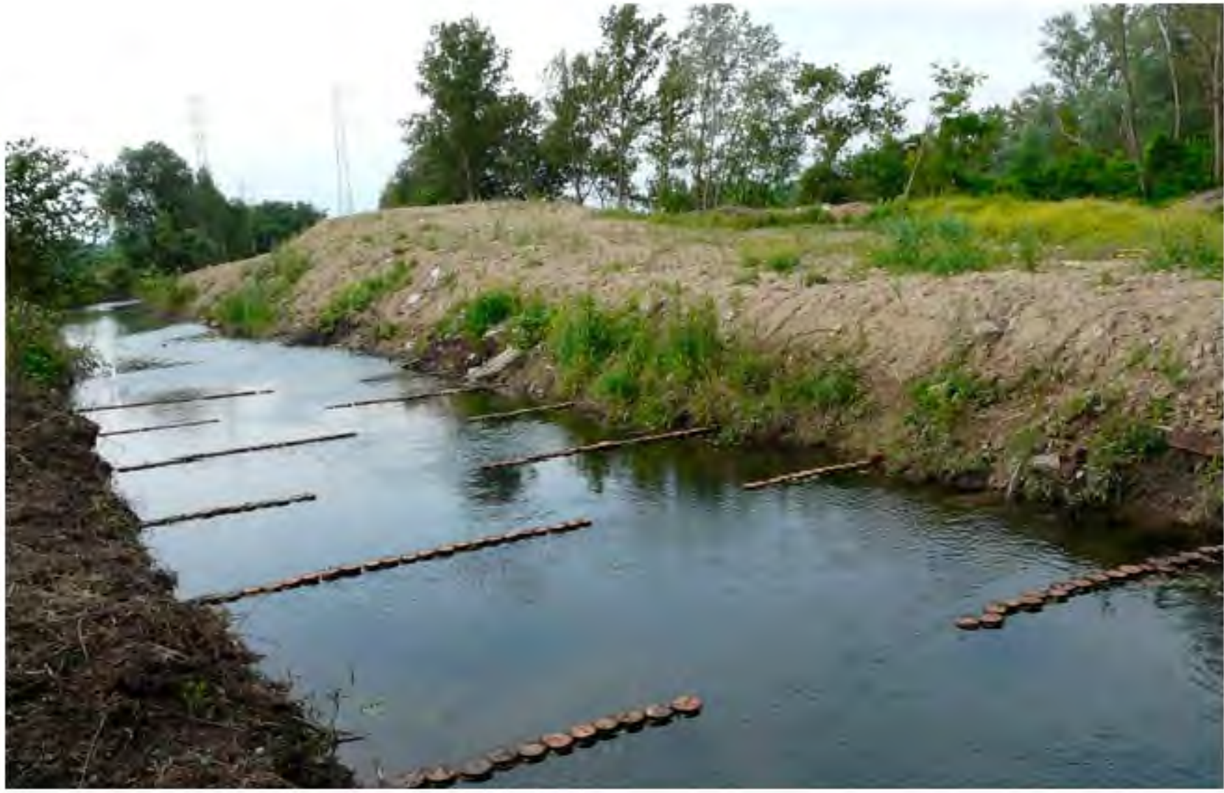
Pose d'épis en pieux pour former à terme de nouvelles banquettes naturelles (Ostwaldergraben à Lingolsheim)
