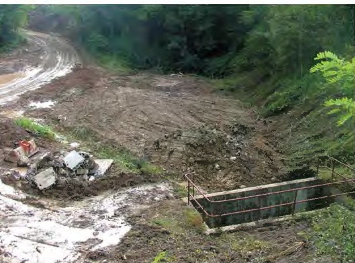
Le Redon aval enterré en 2007, avant travaux.
