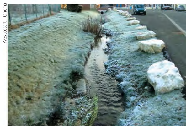
Le ru d'Orval après les travaux, vu depuis l'amont de la zone remise à ciel ouvert :
