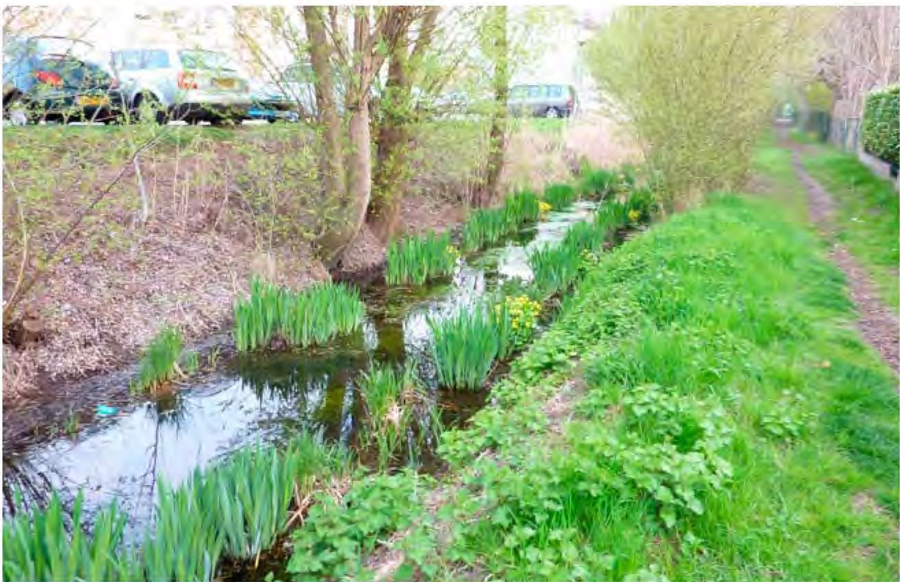
Pose de boudins d'hélophytes , pour éviter les eaux stagnantes, souvent à l'origine de problèmes d'odeurs. (Bannscheidgraben à Geispolsheim-gare)
