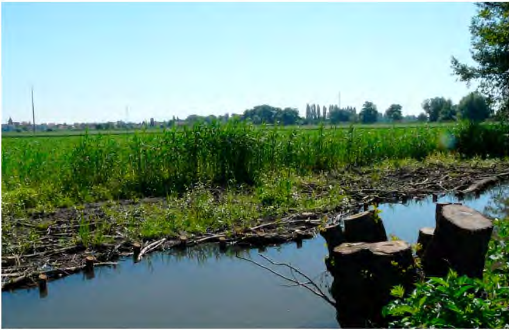
Création de banquettes par la technique de peignes en pieux et branchages. (Muhlbach d'Oberschæffolsheim).
